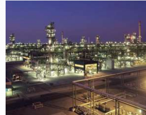
PROJET GASCO HABSHAN (Emirats Arabes Unis)
