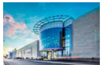
Al - Othaim Mall Dammam / Saudi Arabia
