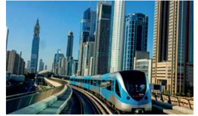
Dubai Metro Dubai / U.A.E.
